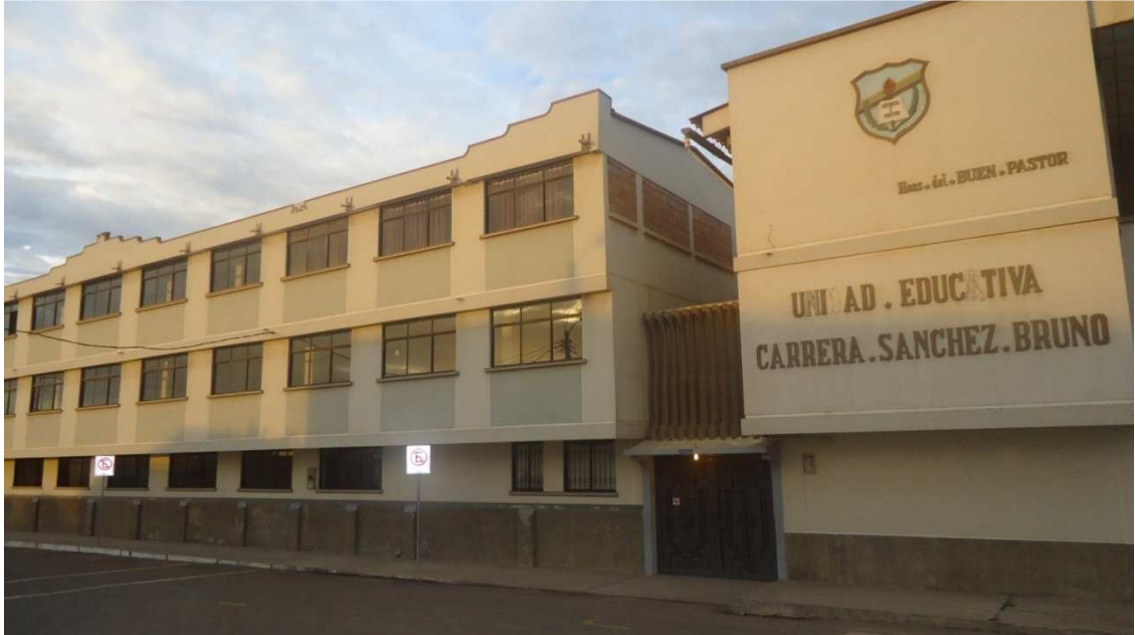
Instalaciones externas de la Unidad Educativa “Carrera Sánchez Bruno”
