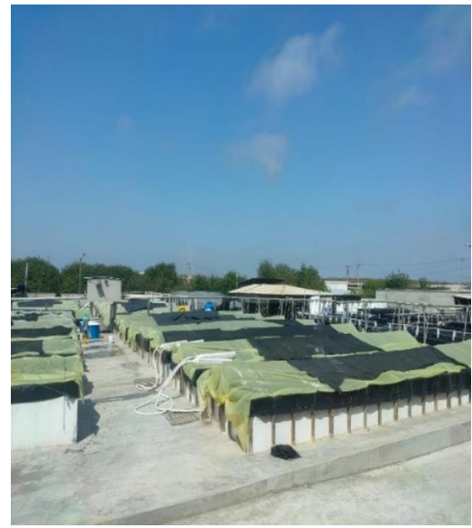
Nota: Observación para la identificación de riesgos.
