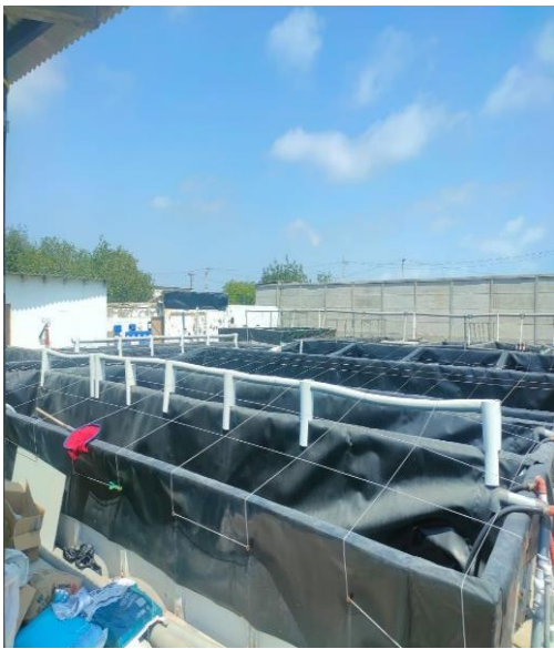
Nota: Observación de la situación actual de los tanques de cultivo
