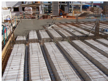
Figura 3.13: Forjado y Vigas. Fuente: Gilva (2012)
