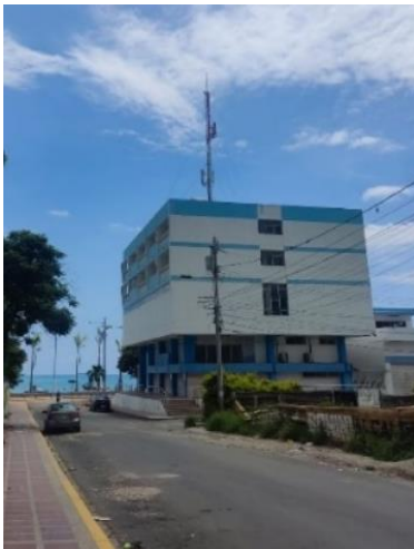
Figura 118. Estación transmisora "La Libertad" Imagen elaborada por el autor
