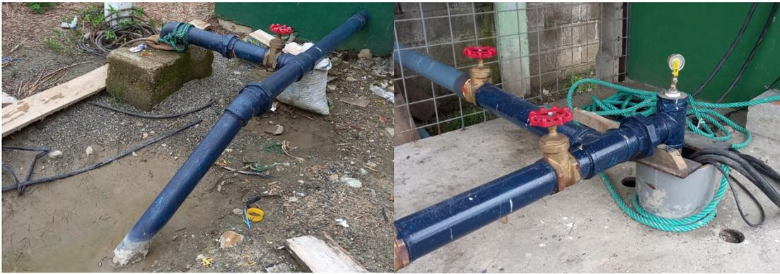
*Ilustración 1: Pozo para captación de agua subterránea.*
