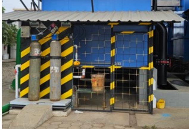
*Ilustración 19: Sistema de desinfección del agua en la PTAP de la cabecera cantonal de Samborondón.*
