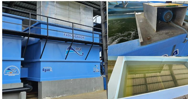
*Ilustración 16: Proceso de coagulación-floculación.*
