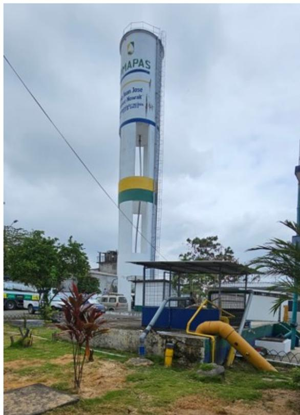
*Ilustración 13: Tanque elevado para abastecer a los tanqueros.
