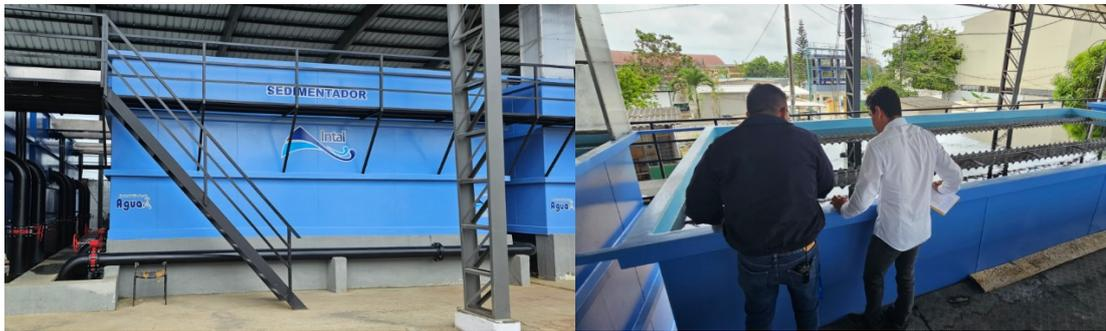
*Ilustración 17: Proceso de sedimentación.*
