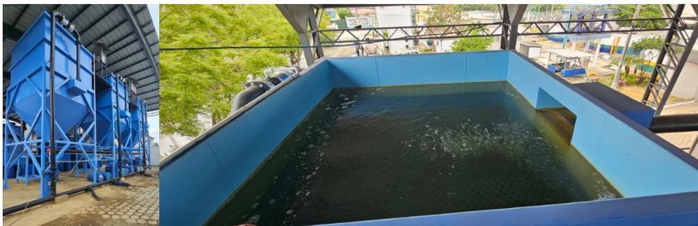
*Ilustración 14: Desarenador en la PTAP de cabecera cantonal de Samborondón.*
