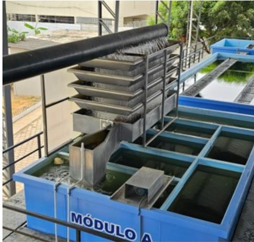
*Ilustración 15: Sistema de aireación en la PTAP de la cabecera cantonal de Samborondón.*
