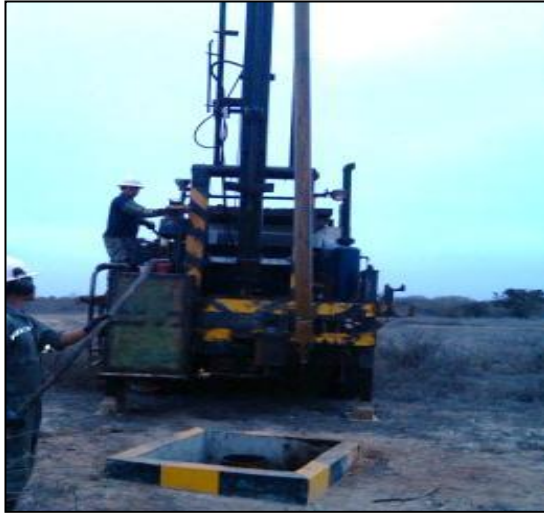
Figura 12: Método de uso con cuchara de herramienta local
