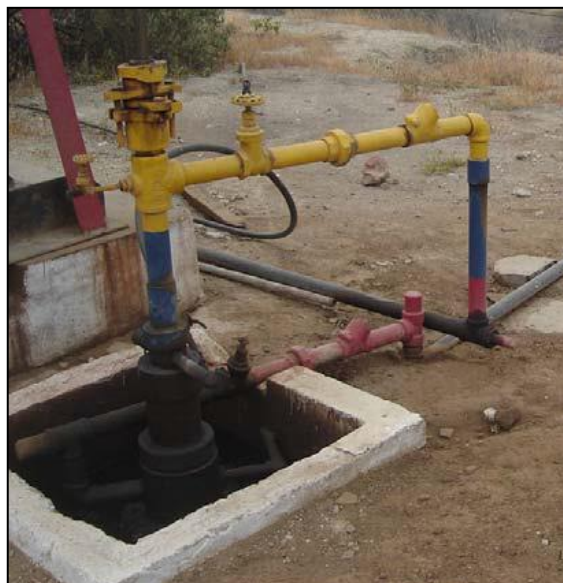
Figura 7: Cabezal del pozo del campo Ancón
