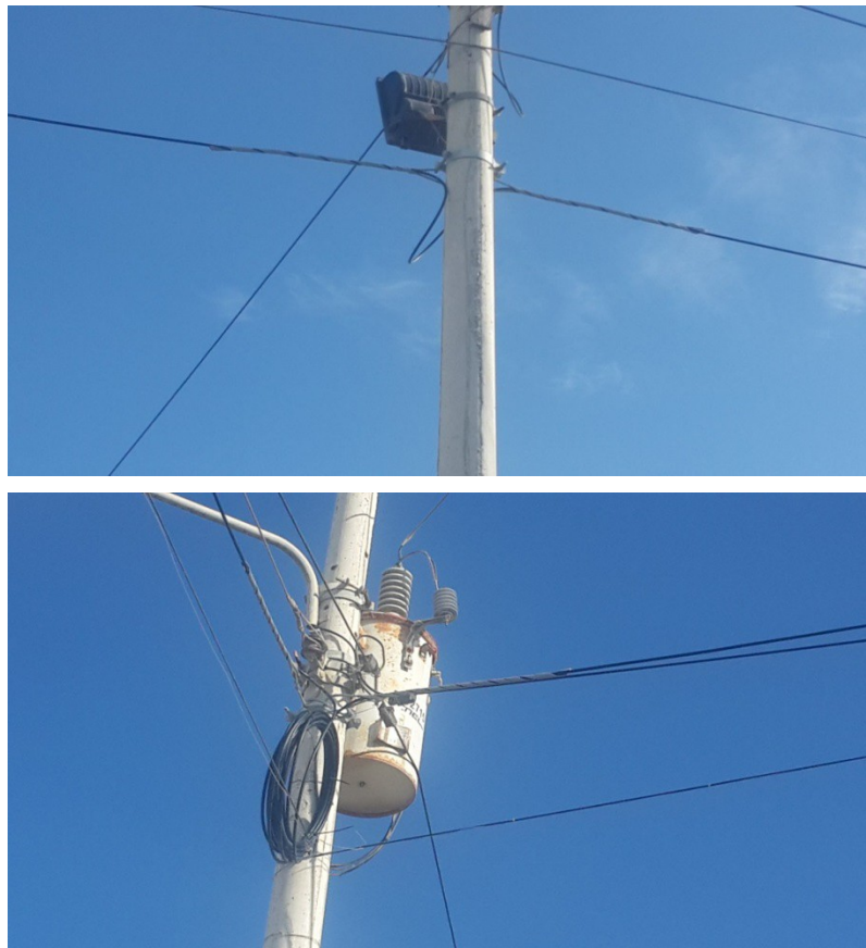
Fuente: Ilustración 20: Paso de FO por los postes Implementación de tesis
