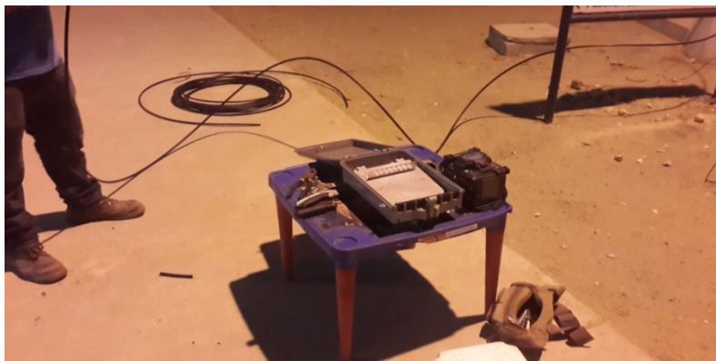
Ilustración 21 Proceso para fusionar de la FO en el BMX –paso 1
