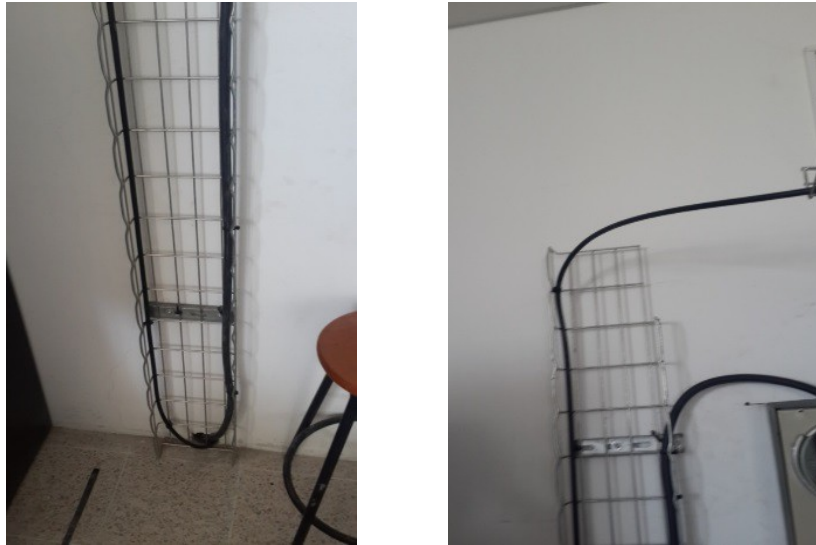
Ilustración 25: Ingreso de la FO al Laboratorio de Electrónica Fuente: Implementación de tesis
