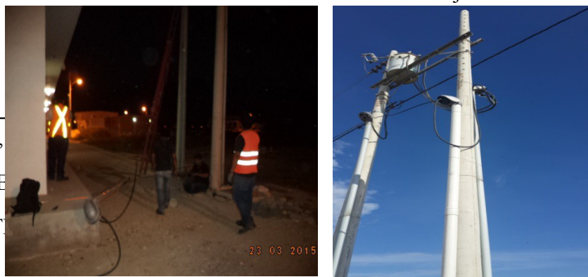
Ilustración 19: Instalación del tubo Bajante
