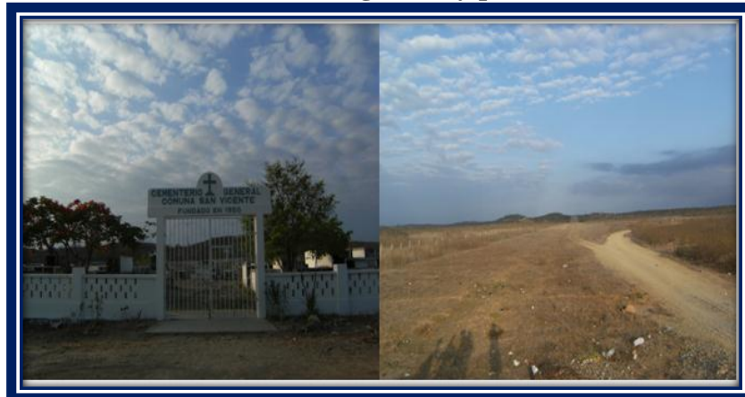
FIGURA N° 11: Cementerio general y poliducto subterráneo
