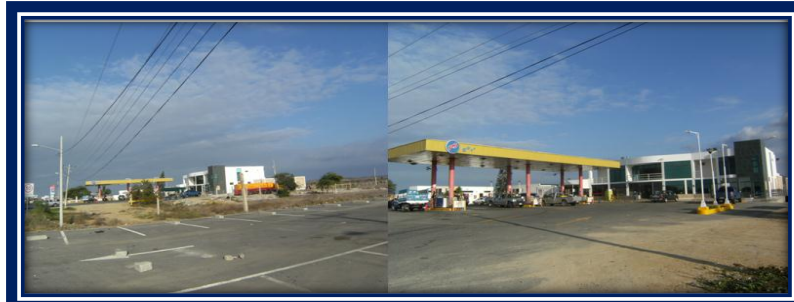
FIGURA Nº 3: Gasolinera entrada Comunidad de San Pablo
