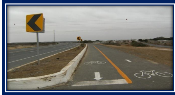
FIGURA N° 18: Ciclovía al ingreso de la Comuna San Vicente
