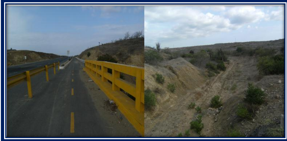
FIGURA N° 8: Puente sobre río Asagnones en la comunidad de Cerro Alto
