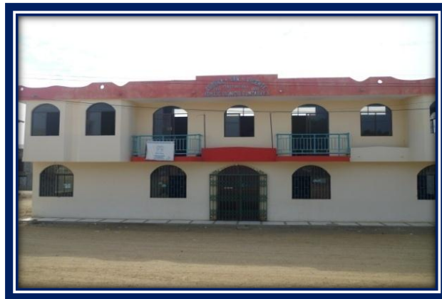
ANEXO N° 18: Imagen de la Casa Comunal de San Vicente
