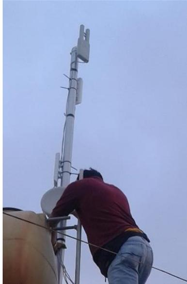
**Figura 5.22:** Ubicación de equipos en repetidora
