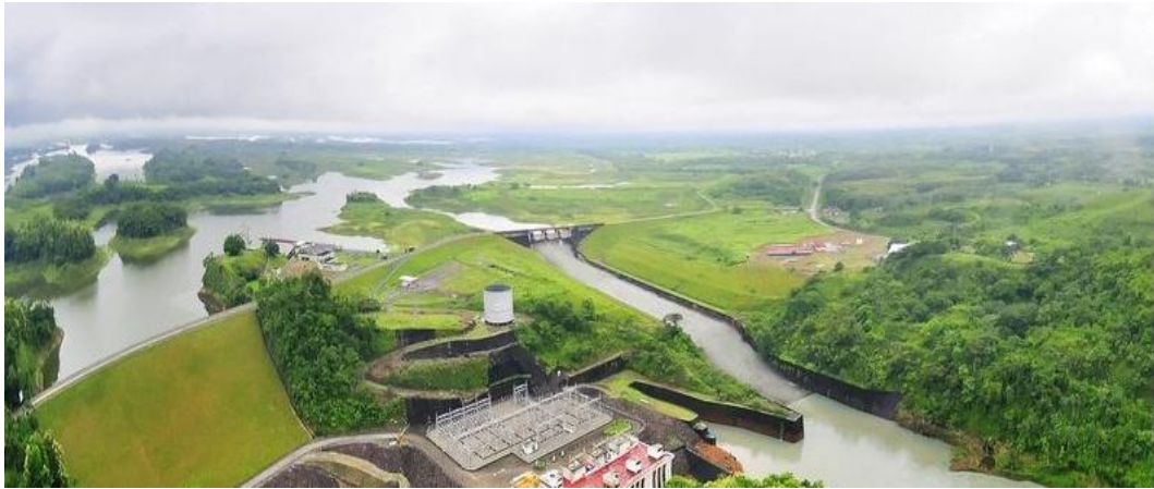
Figura 2.4 Central Hidroeléctrica Daule Peripa Fuente: Corporación Eléctrica del Ecuador, https://www.celec.gob.ec
