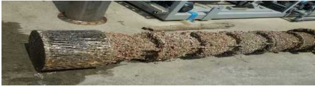
Figura 21. Filtros de las bombas de captura de agua de mar, cubierta con materia orgánica. Fuente: Tomada en campo por trabajadores del Consorcio GLP Ecuador 37
