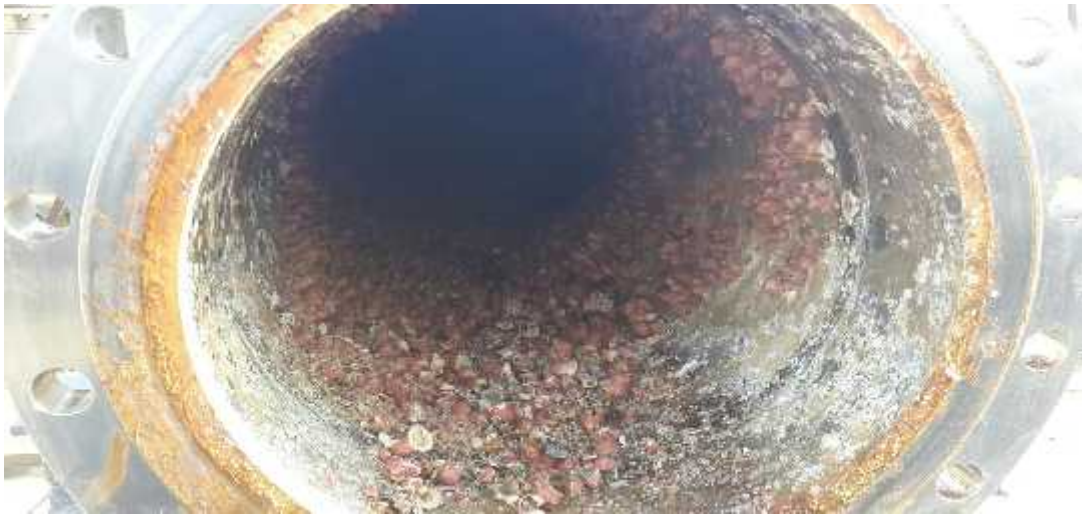
Figura 25. Corte de tubería dúplex, con materia orgánica adherida.
