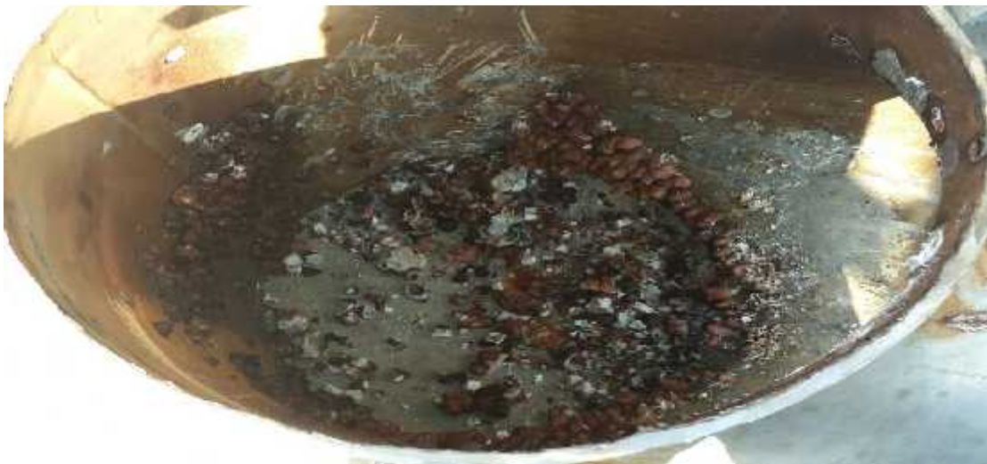
Figura 26. Corte de tubería dúplex, con materia orgánica adherida
