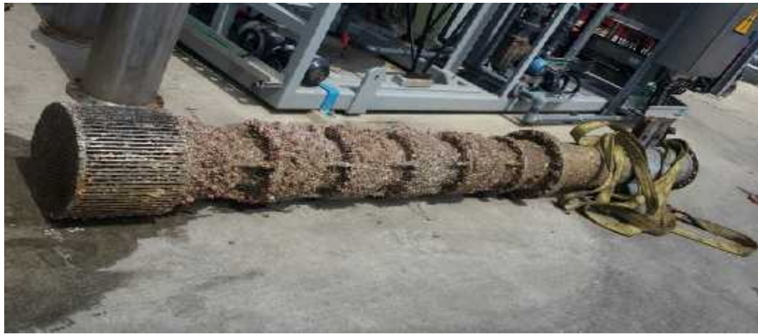
Figura 22. Filtros de las bombas de captura de agua de mar, cubierta con materia orgánica. Fuente: Tomada en campo por trabajadores del Consorcio GLP Ecuador 38
