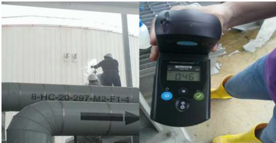
Figura 13. Resultado del análisis en intercambiadores de calor grupo de frío (aguas arriba). Tomada en campo por Santiago Abel Silva Tomalá 24
