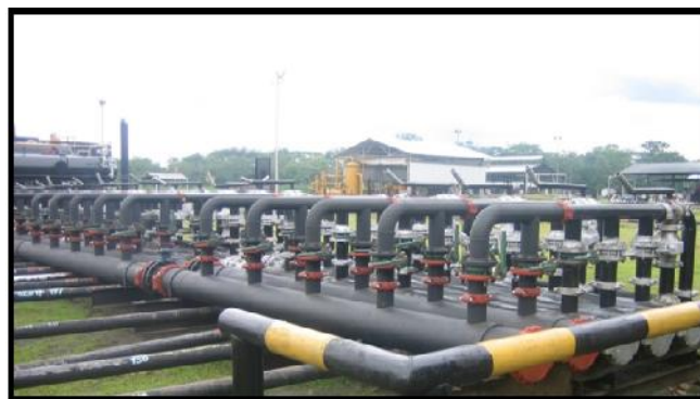
Figura 1.14. Manifold estación Sacha Central
