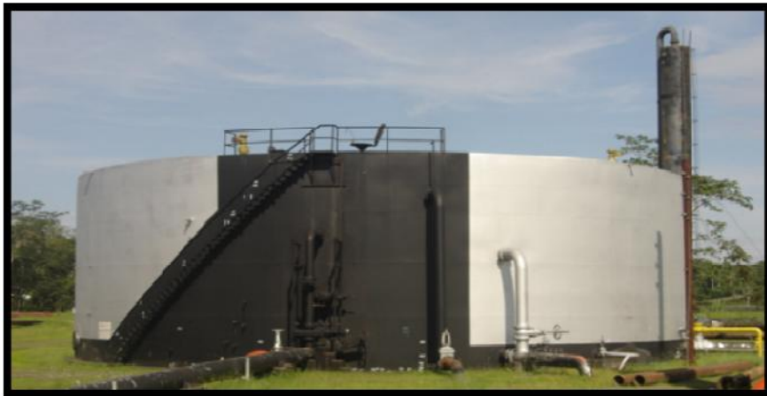
Figura 1.17 Tanque de lavado estación de Sacha Central Fuente: (Orrala J., Tomalá J.)
