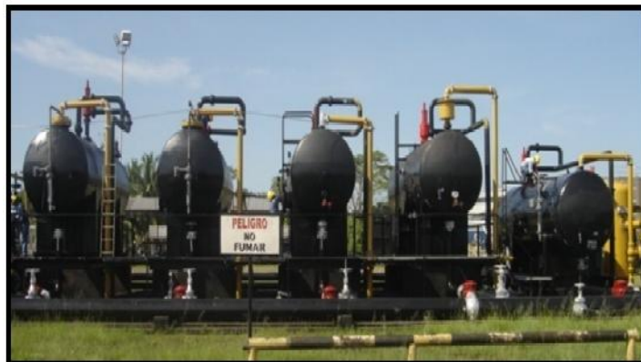
Figura 1.15. Separadores de producción estación Sacha Central Fuente: (Orrala J., Tomalá J.)
