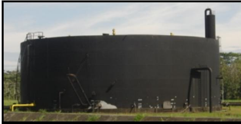
Figura 1.16 Tanque de lavado estación de Sacha Central Fuente:(Orrala J., Tomalá J.)
