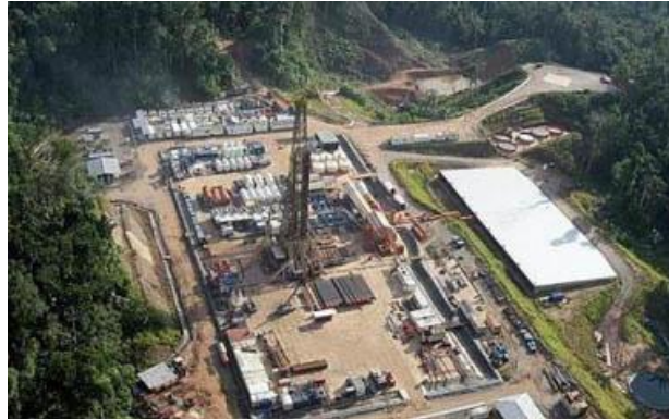
Figura 1.13 Vista superior de unas de las instalaciones del Campo Sacha
