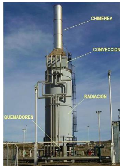
Figura 5: Partes constitutivas de un horno Fuente: FLARGEN
