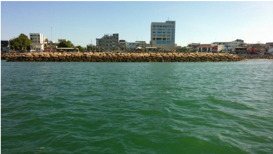
Foto 2. Estación de muestreo 2 – Escollera 4.
