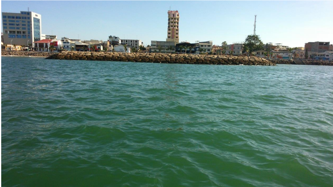
Foto 3. Estación de muestreo 3 – Escollera 3
