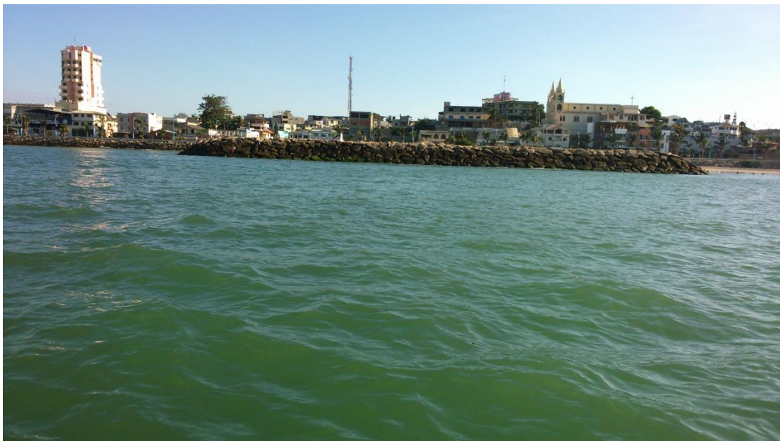
Foto 4. Estación de muestreo 4 – Escollera 2
