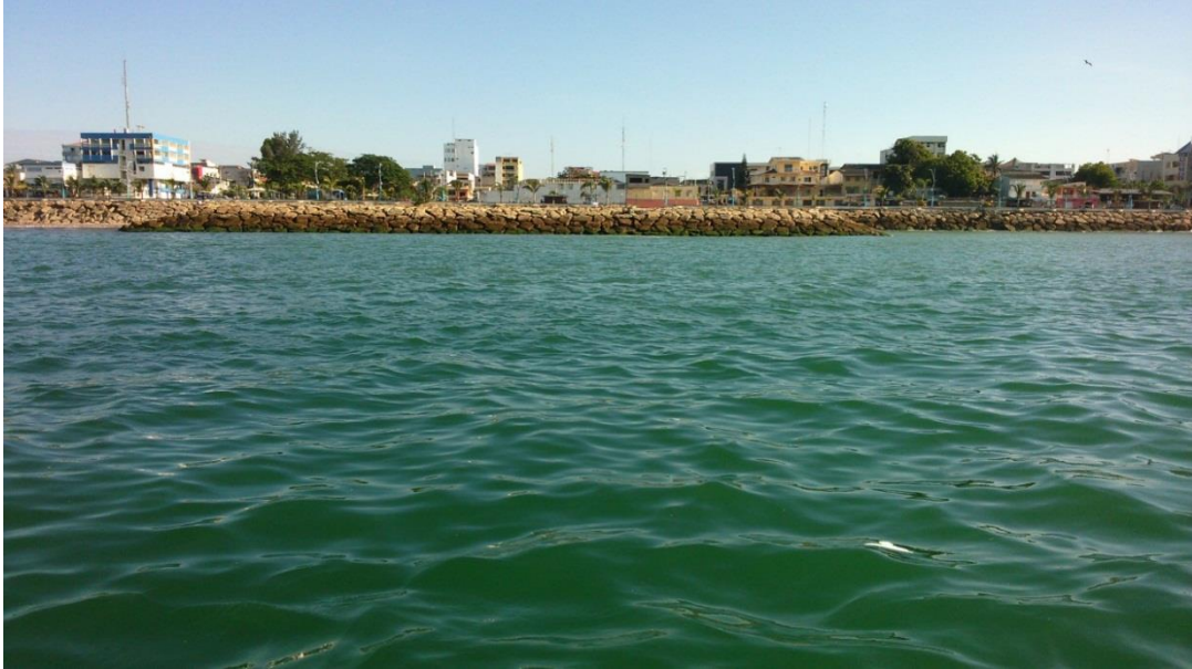
Foto 1. Estación de muestreo 1 – Escollera 5.
