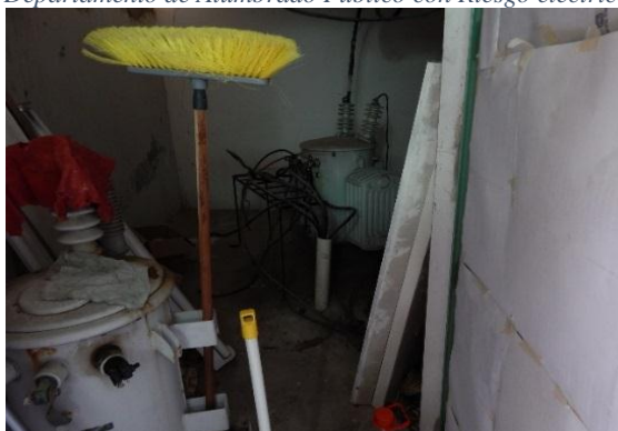
Imagen 5 Departamento de Alumbrado Público con Riesgo eléctrico
