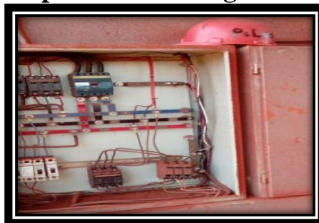
Imagen N° 23. Equipo de protección en lugar no adecuado
