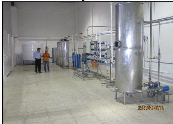
Imagen N° 25 Área de purificación
