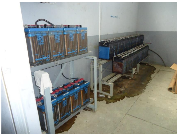
Imagen N° 13: Baterías en mal estado en la cabina de control.
