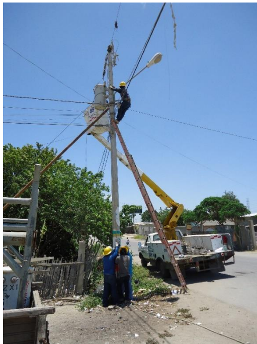
Imagen N° 11: Montaje de transformadores.
