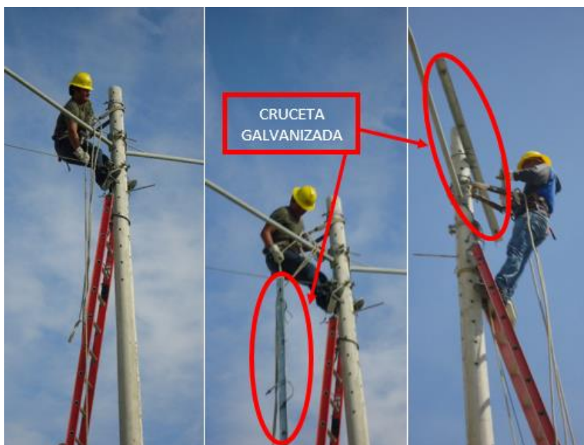
Imagen N° 12: Montaje de cruceta galvanizada.
