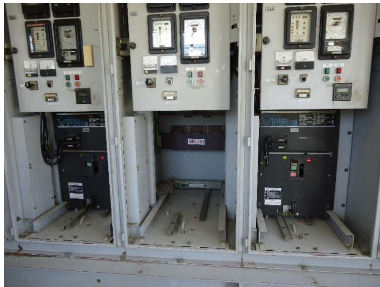
Imagen N° 4: Alimentadores de 13.8 Kv., sin tapa de protección.
