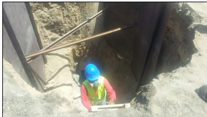
Figura N° 15: Instalación de tuberías por parte del personal de HIDROPLAYAS E.P.
