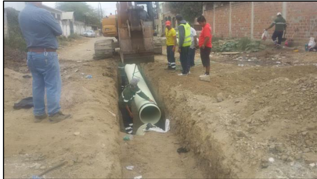
Figura N° 14: Instalación de tuberías por parte del personal de HIDROPLAYAS E.P.
