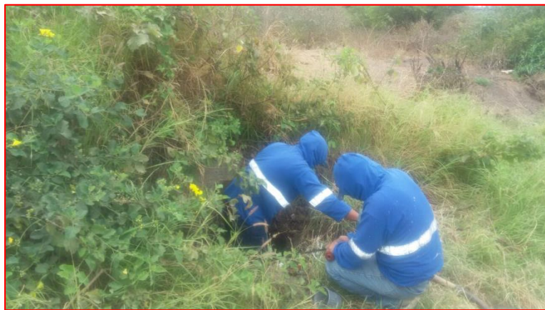
Personal de HIDROPLAYAS E.P., realizando limpieza en canal de desfogue de aguas servidas
