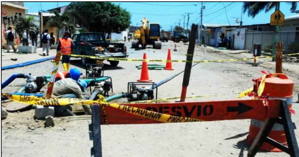
Figura N° 6: Línea de revisión de alcantarillado de Playas
