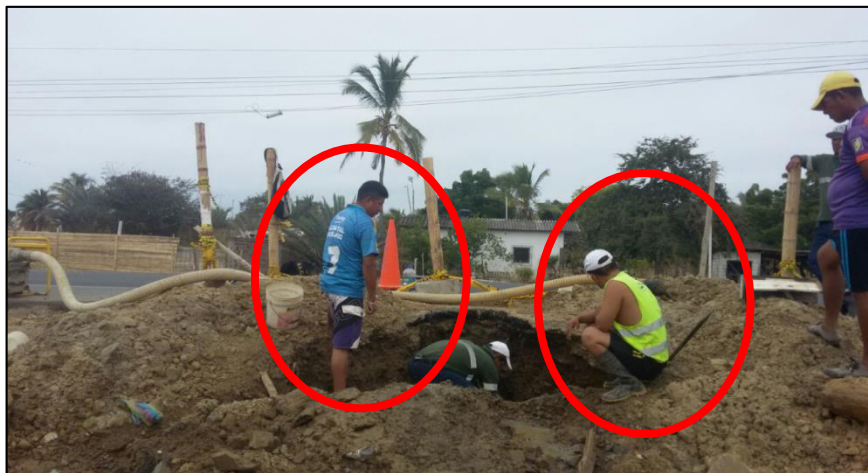
Figura N° 16: Instalación de tuberías por parte del personal de HIDROPLAYAS E.P. Nótese que no utilizan el Equipo de Protección Personal
