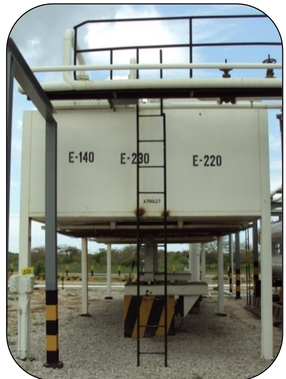
Figura N° 15: Aeroenfriadores de aceite, gasolina de reflujo y natural
