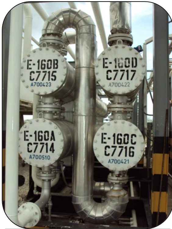
Figura 12: Intercambiadores de calor
