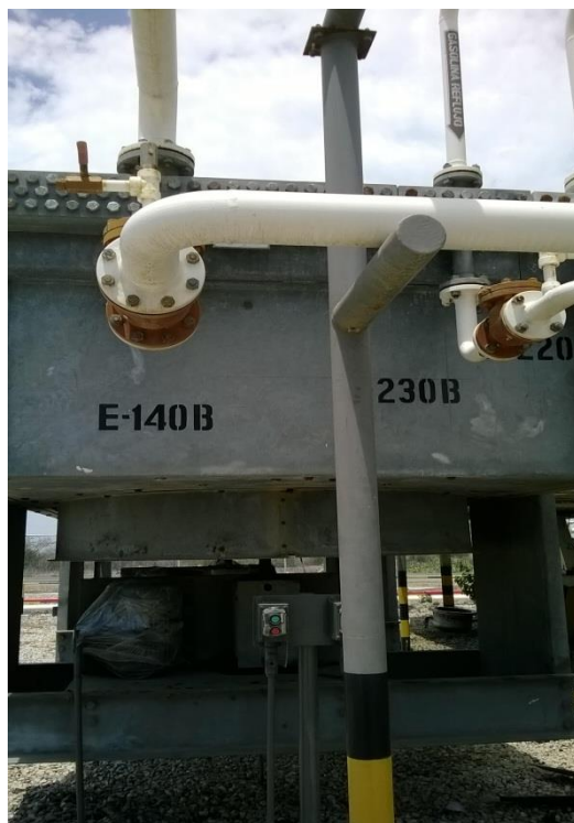
Figura N° 14: Aeroenfriadores de aceite
