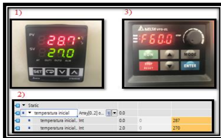
Figura 61: Prueba de comunicación Controlador de temperatura: Elaborado por el autor
