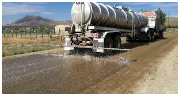
Figura 6. Riego de zycobond en una vía.
