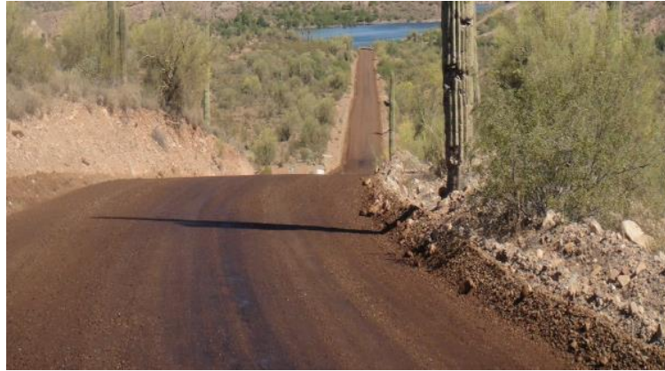
Figura 5. Vía impermeabilizada con zycobond.
