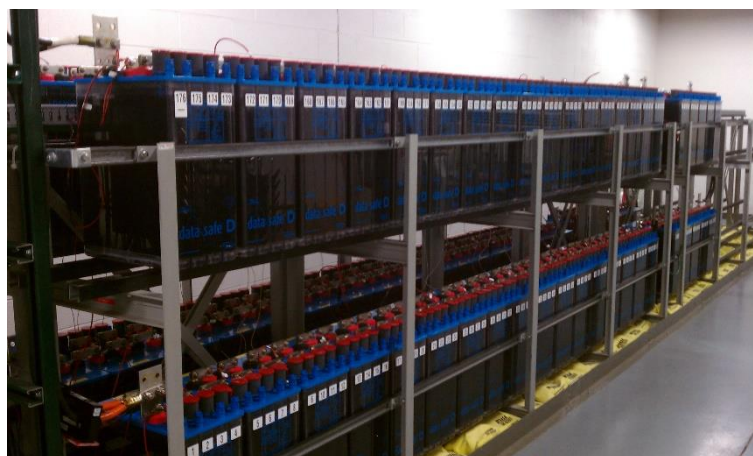
Ilustración 11 Banco de Baterías [30]
