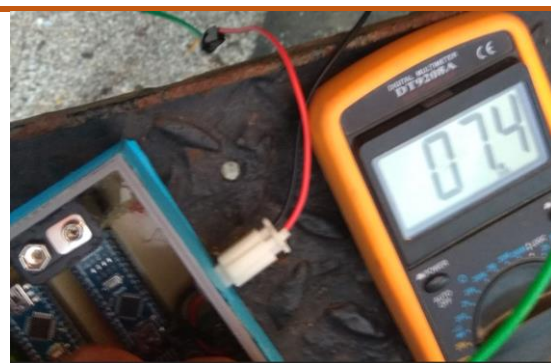
Ilustración 69 Tensión de salida regulada que va directo a la batería.
