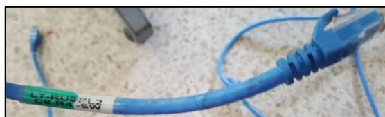
Figura 62. Etiquetado de cable para la conexión entre PL2-SW. Tomada por Joselyn Torres.
