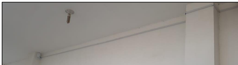
Figura 50. Colocación de canaletas. Elaborado por Joselyn Torres.
