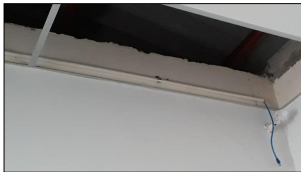
Figura 59. Montaje de cableado airCam. Tomada por Joselyn Torres.
