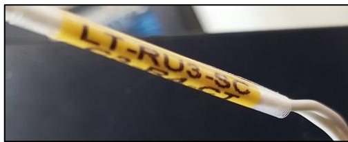
Figura 53. Etiquetado del cable de la conexión entre SC y CT. Elaborado por Joselyn Torres.
