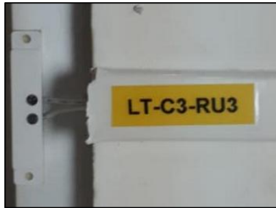
Figura 54. Etiquetado de canaleta. Tomada por Joselyn Torres.
