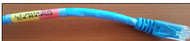
Figura 61. Etiquetado de cable para la conexión entre CA-Po2. Tomada por Joselyn Torres.
