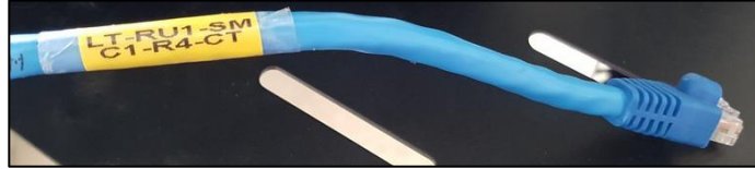
Figura 48. Etiquetado del cable de la conexión entre SM y CT. Elaborado por Joselyn Torres.
