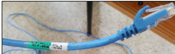
Figura 64. Etiquetado del cable de red del PL1 al SW. Elaborado por Joselyn Torres.
