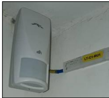
Figura 49. Etiquetado de canaleta. Tomada por Joselyn Torres.
