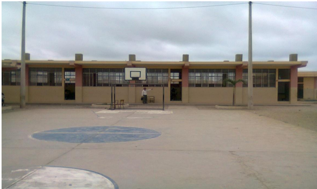
DIRECTOR SEÑALANDO EL LUGAR DE LA EJECUCIÓN DEL PROYECTO
