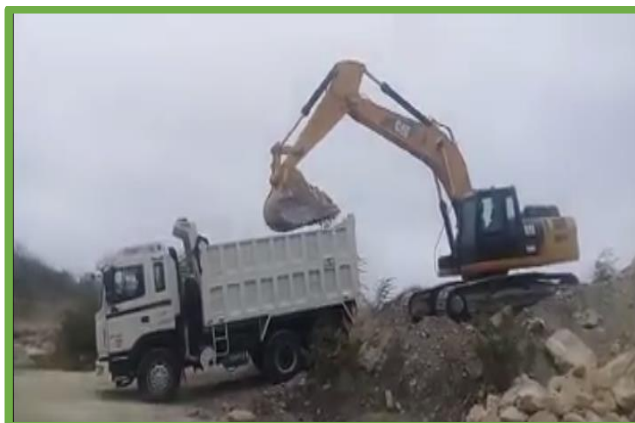
Figura 8 Relleno (material de construcción caliza)
