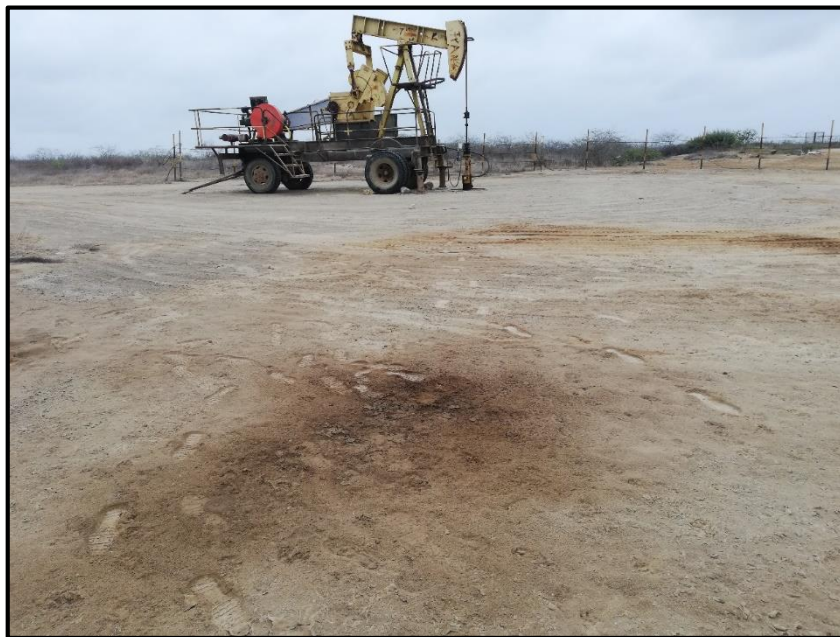
Figura 51. Pozo PETROPOLIS 0113 con suelo contaminado por petróleo.
