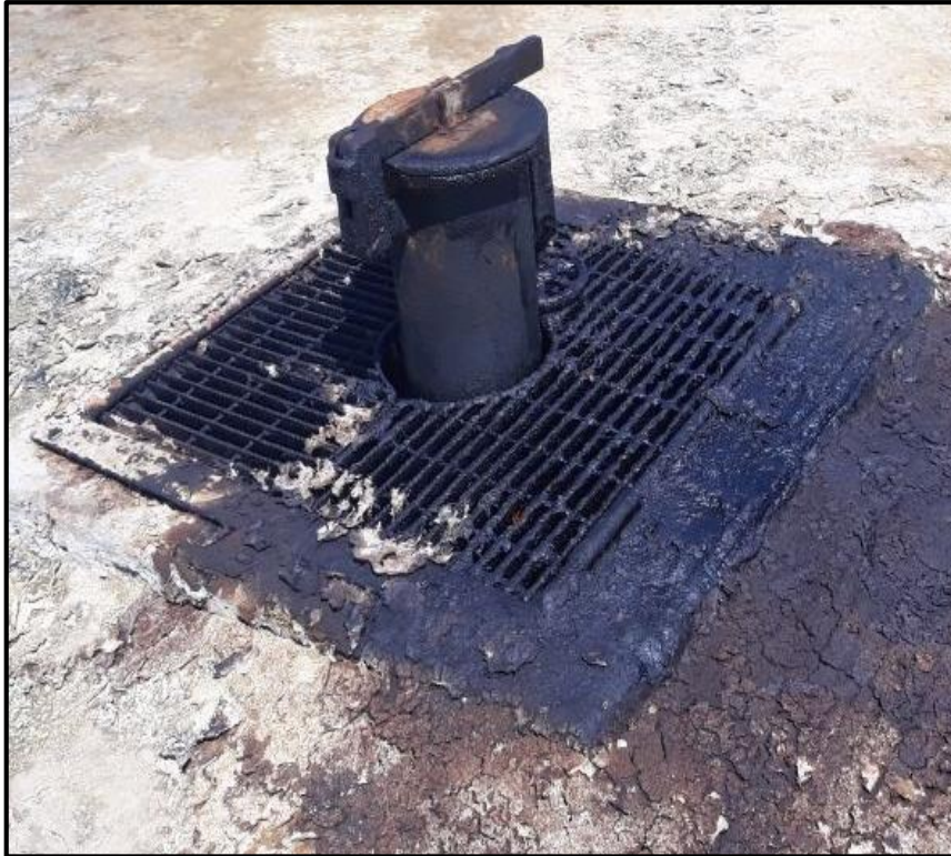
Figura 46. Pozo SPA 0079 con suelo contaminado por petróleo.
