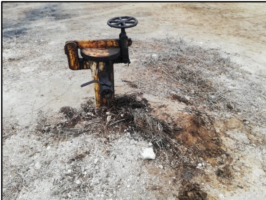
Figura 47. Pozo SPA 0081 con suelo contaminado por petróleo.
