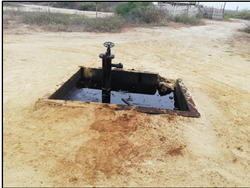
Figura 48. Pozo SPA 0085 con suelo contaminado por petróleo.
