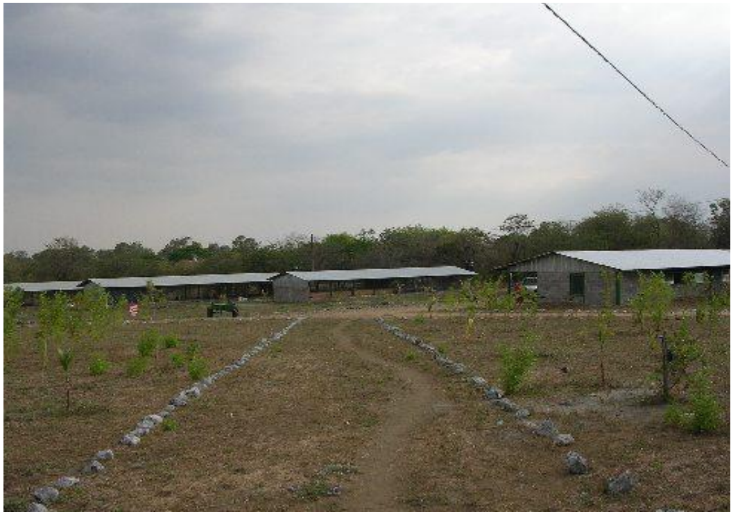
1. Espacio físico de la infraestructura
