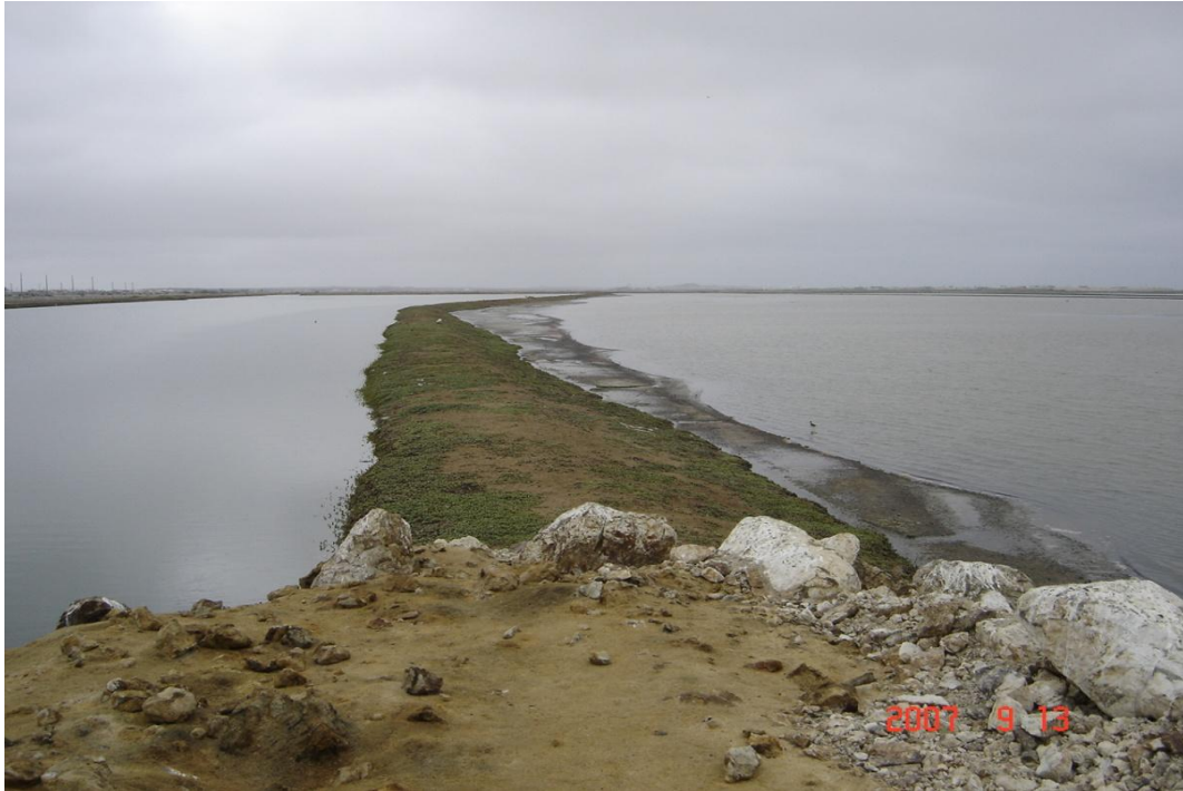
Foto # 29. Dique de anidación # 2.
