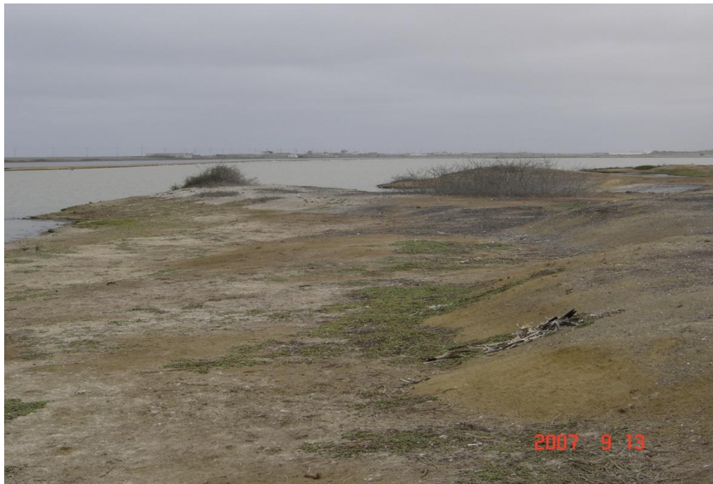
Foto # 32. Dique de anidación # 10.
