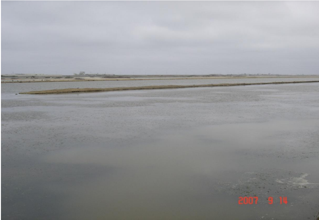
Foto # 33. Dique de anidación # 13.
