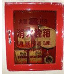
Figura N° 3 Hdrante Interior Fuente: www.bomberosconcepcion.com
