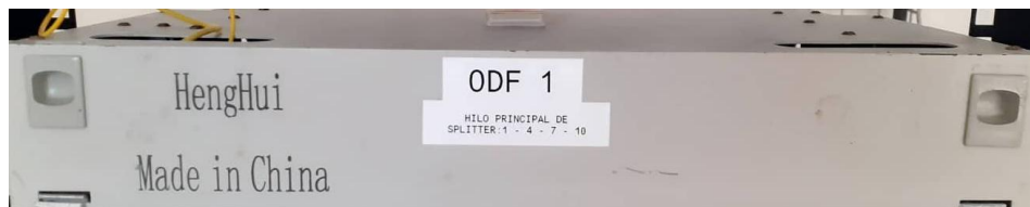
Figura 84. Etiquetado del ODF Fuente: Investigación de campo (2022)
