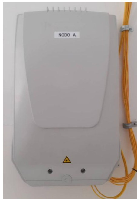
Figura 88. Etiquetado del FDB nodo A Fuente: Investigación de campo (2022)
