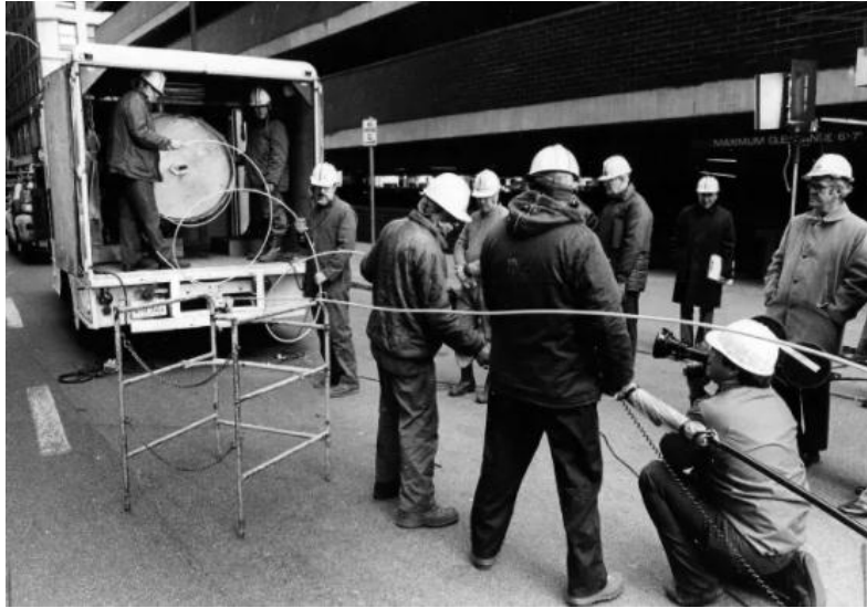
Figura 5. Instalación de la primera red de fibra óptica.
