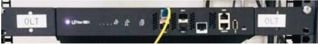
Figura 86. Etiquetado de OLT Fuente: Investigación de campo (2022)
