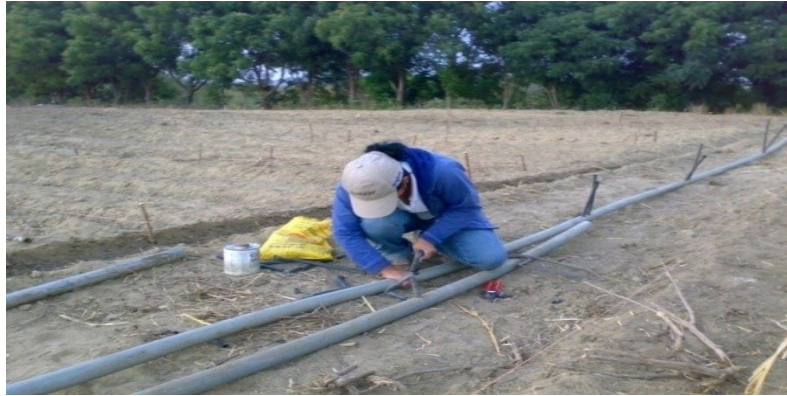
Figura 1A. Instalación de las tuberías, sistema de riego por goteo.
