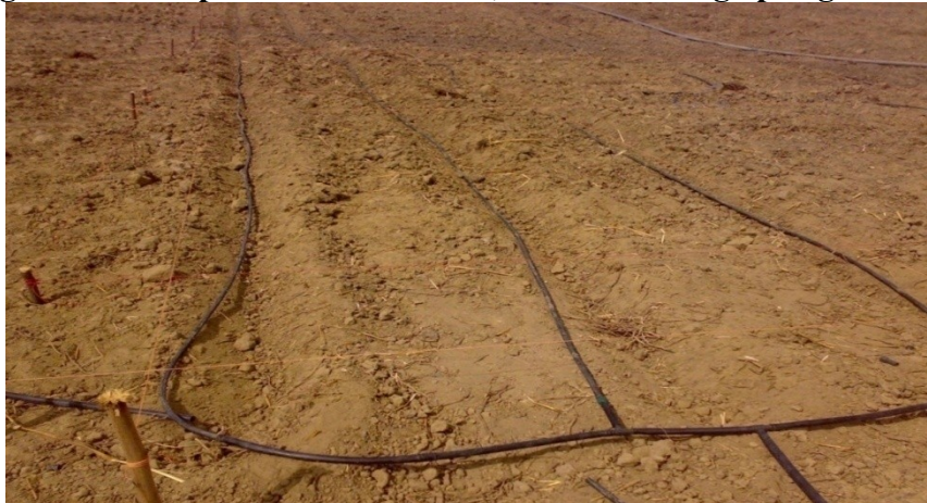
Figura 3A. Instalación de tuberías, riego por goteo
