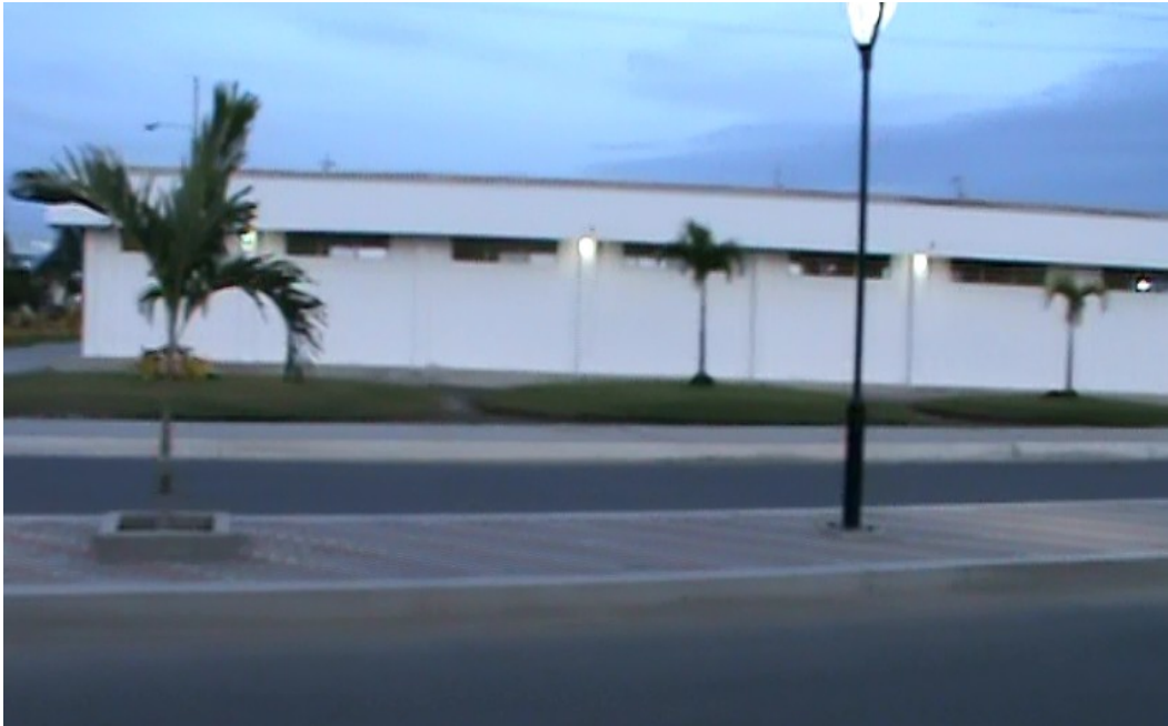
Figura 14A. Edificio de aulas sector “U”
