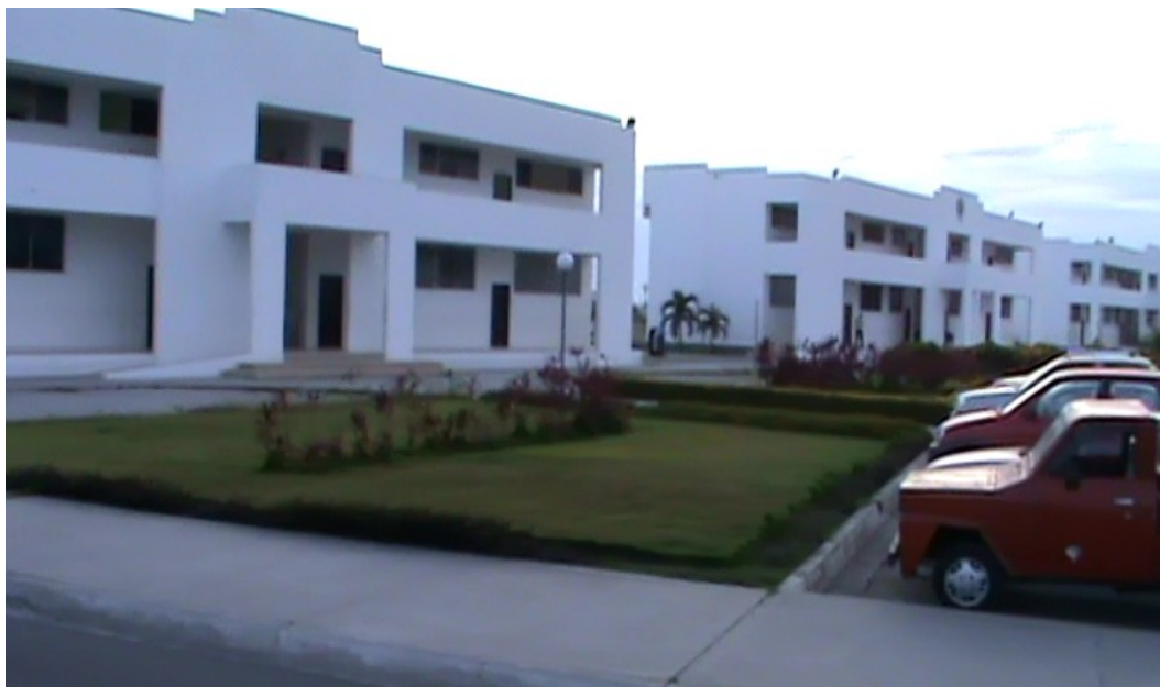
Figura 19A. Sector “Edificio de aulas # 1 de 2 plantas”
