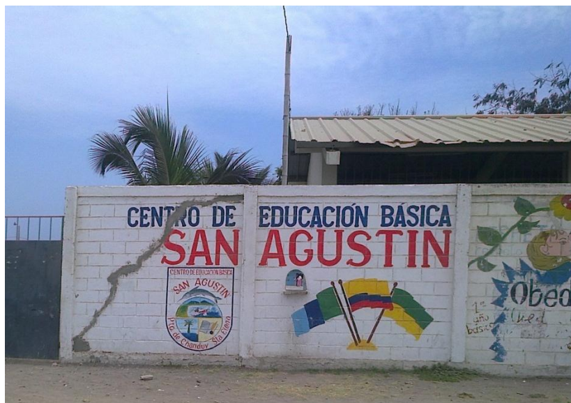
Fotografía # 1.- Vista panorámica CEB “SAN AGUSTÍN”
