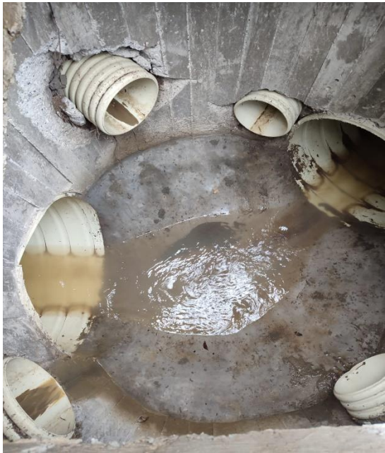
Cámaras del sistema de alcantarillado pluvial sin residuos
