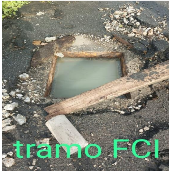
Desbordamiento en Tramo FCI
