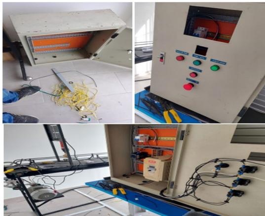
*Figura 98. Adquisición y armado de tablero eléctrico de control para el sistema*
