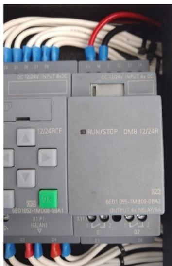
**Figura 56.** Módulo de ampliación 6ED1055-1MB00-0BA2 para controlador LOGO
