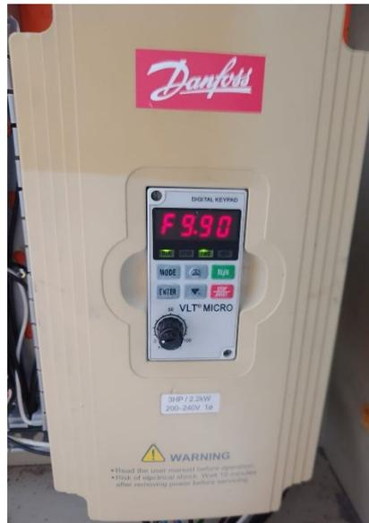
*Figura 117. Pruebas de ajustes en parámetros requeridos para un correcto arranque de motor y puesta en marcha de la banda*
