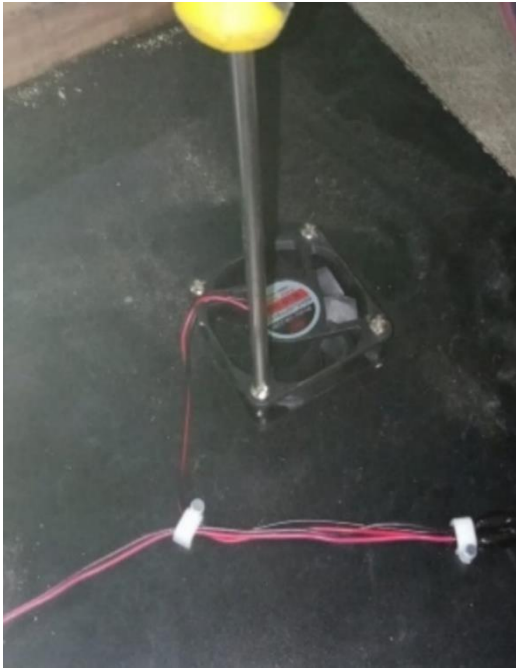
Figura 5A. Instalación de ventiladores
