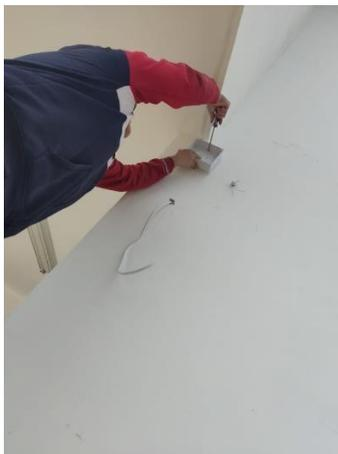
*Figure 104 IMAGEN REALIZANDO EL MONTAJE DE LA CAJA DE PASO PARA UBICAR LA FUENTE DE ENERGÍA*
