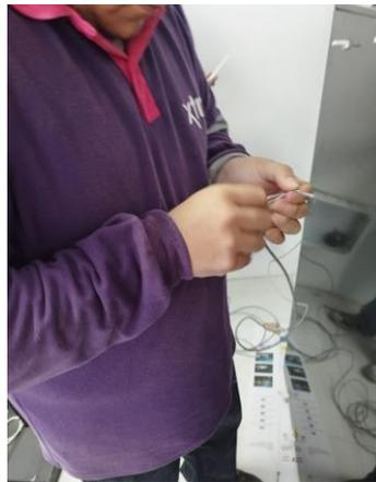
*Figure 89 PONCHADO DE CABLE UTP*
