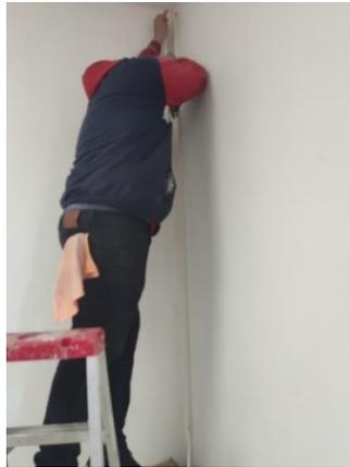
*Figure 103 IMAGEN REALIZANDO EL MONTAJE DE LA CANALETA Y PASO DE CABLE ELÉCTRICO*
