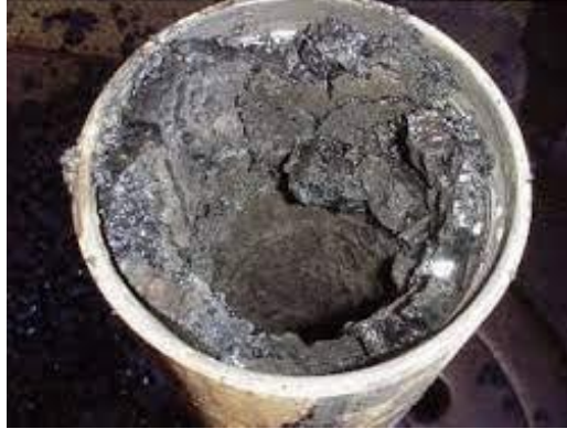
Figura 1. Presencia de sólido asfáltico en casing de producción, requerida limpieza mecánica.
