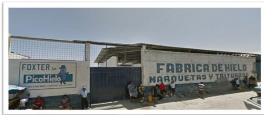
Figura 14. Vista frontal de la Fábrica “FOXTER PICOHIELO S.A.”
