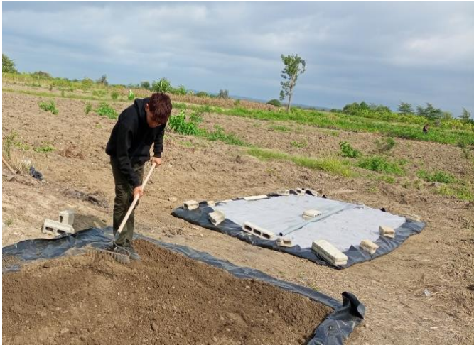
Ilustración 1. Preparación del suelo para solarización
