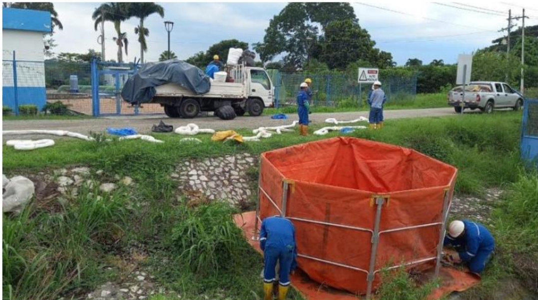
Trabajadores de diversas entidades públicas realizan tareas de limpieza en el canal tras el derrame. @EPPETROECUADOR
