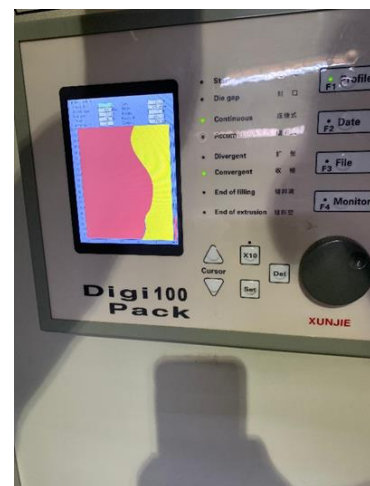
Imagen 4. Panel PLC de mando
