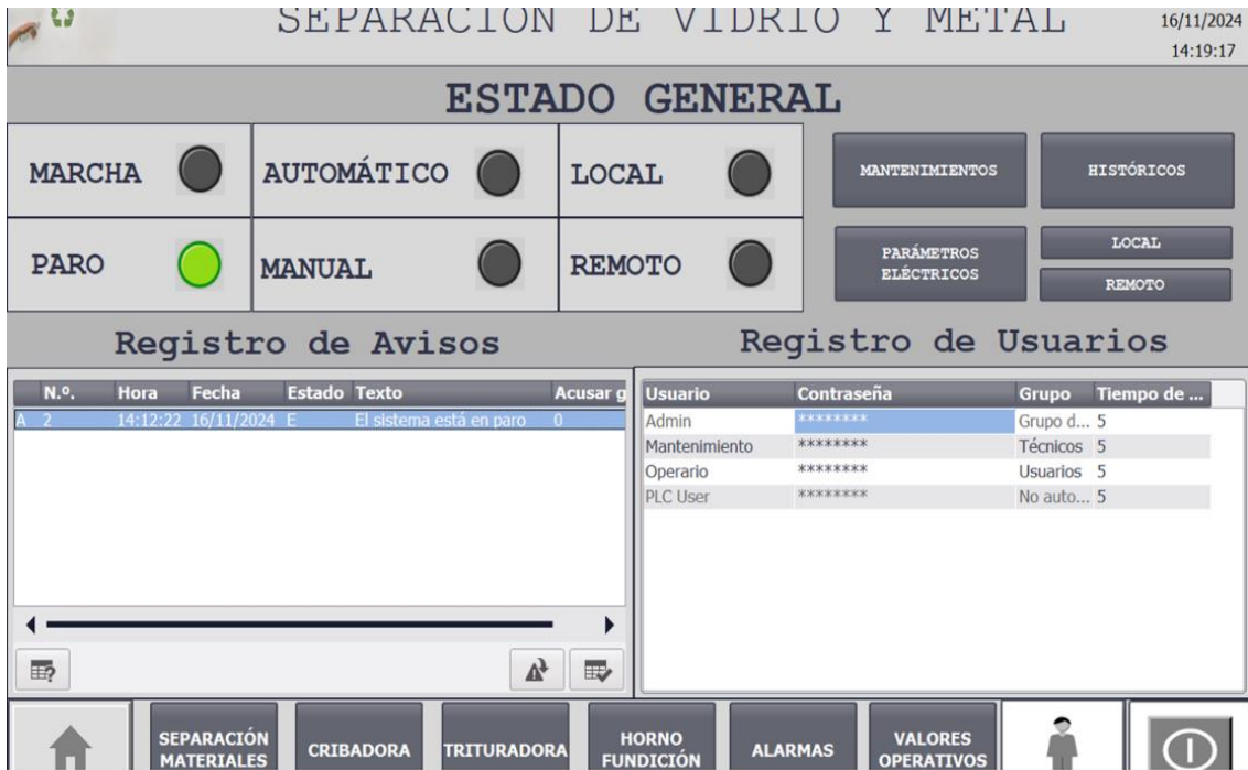
figura 16. Estado general del proceso
