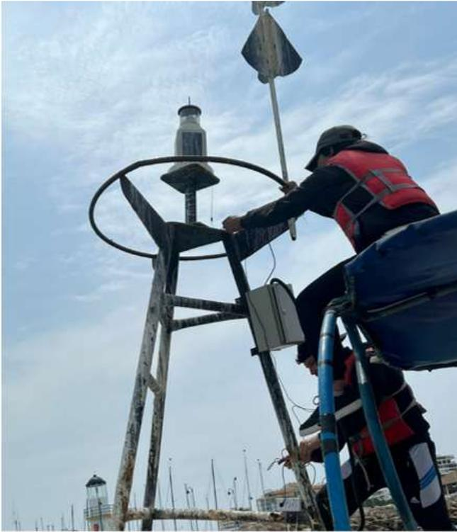
*Fig. Anexo 2 Instalación de panel solar y antena inalámbrica*
