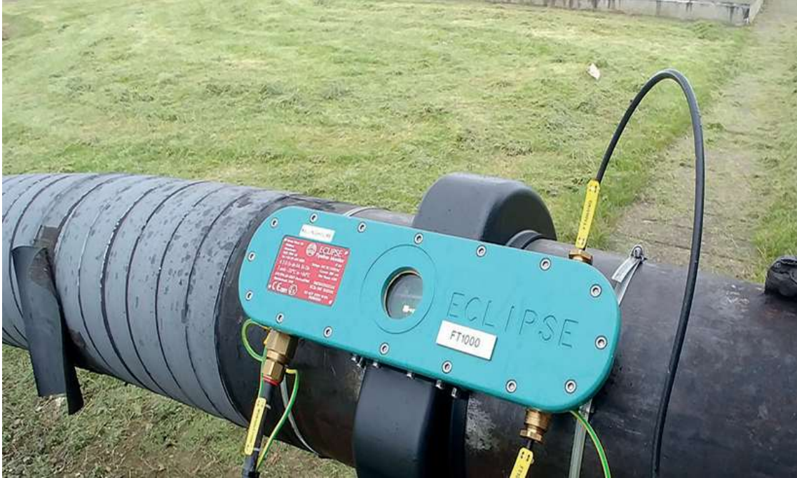
Figura 15. Instalación de hardware Eclipse de Atmos en tubería de transporte de hidrocarburos y derivados.
