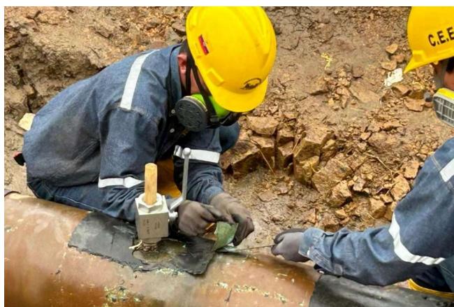
Figura 6. Reparación de poliducto. Tomado de Petroecuador.
