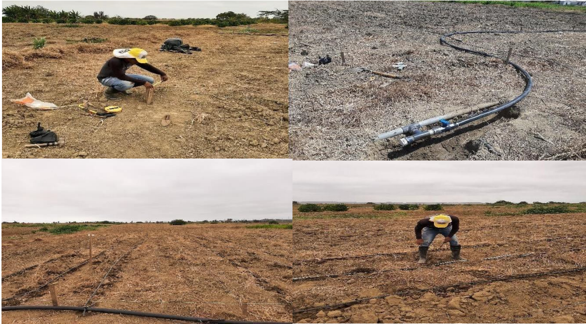
Figura 3A. Delineamiento del terreno e instalación del sistema de riego
