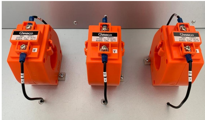
Figura 45. Conexión física y etiquetado de los Transformadores de corriente. Fuente: [24].
