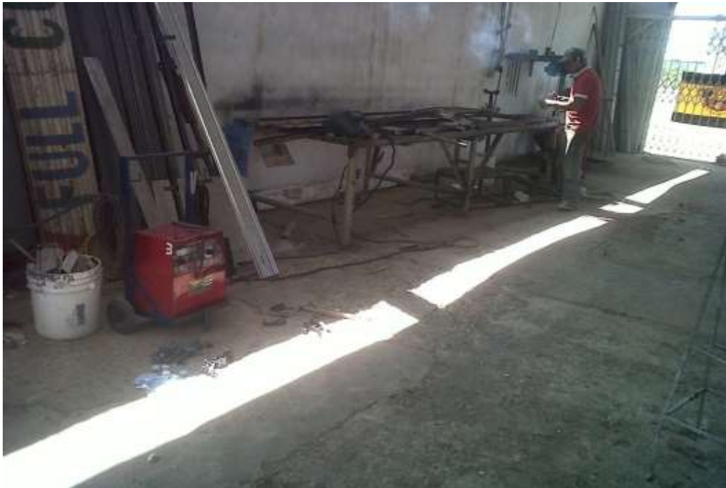
Lugar: Área de soldadura Tomada por: Patricia Perero Panchana
