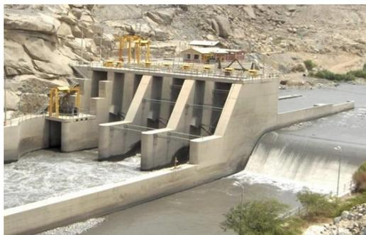
Según el CPE INEN 5, (1997) la estructura de captación debe contar con una capacidad suficiente para derivar al sistema de agua potable un caudal mínimo que sea 1,2 veces el caudal máximo diario esperado al final del período de diseño. Las obras de captación difieren se diferencian según el tipo de fuente de agua, su ubicación y la escala del proyecto.
